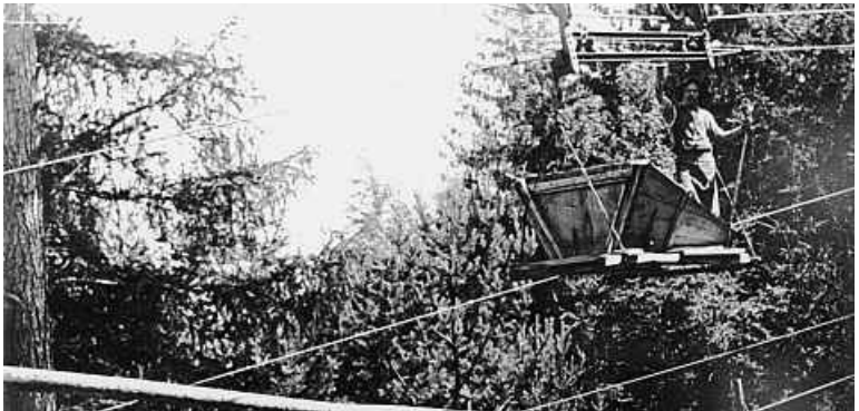
Umbauarbeiten an der Materialseilbahn für die Zulassung als Personenschwebbahn
